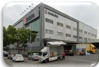
大雅二廠 - 熱水器、瓦斯爐
