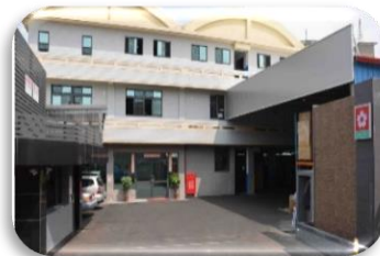
神岡廠 - 油煙機
